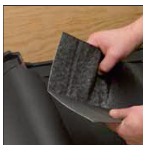
Inddækningsbåndet bukkes efter samlingen på bagsiden.
