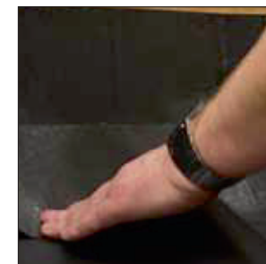
Båndet formes ned i bølgen. Der glattes og presses, så der kommer en 100% vedhæftning.
