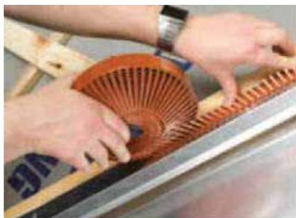
Fuglegitteret placeres på blindfalsen med gitterne ud mod skotrende.
