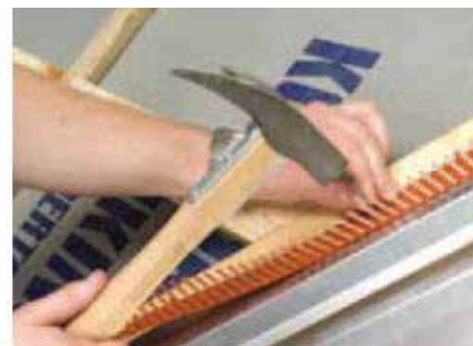
Fuglegitteret fastgøres med vejrbestandige papsøm pr. 25 cm.
