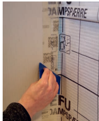
Samlinger mellem tilstødende vægge m.m. og dampspærren er lige så vigtige som samlinger mellem dampspærrebanerne.
