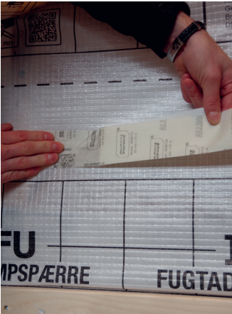
Tapen placeres centreret på overlappet.
