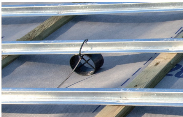
Der monteres 1 undertagsstrammer pr. m 2 undertag.
